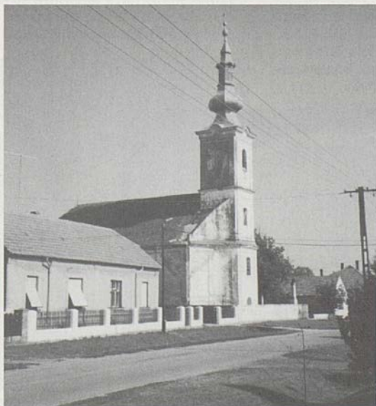
Die renovationsbedürftige Kirche der ungarischen Partnergemeinde Nagydotsza
