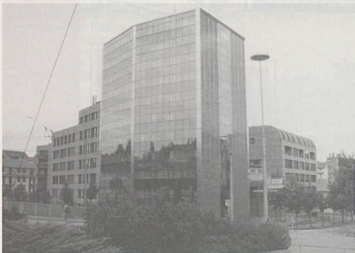
Das Finanzgebäude wurde total renoviert.
