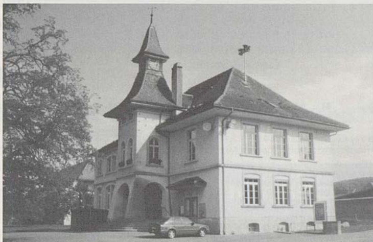
Das Schulhaus wird etappenweise renoviert.
