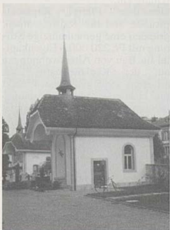
Nach der Renovation der Pfarreiwirtschaft wurden nun auch die beiden Kapellen auf dem Friedhof restauriert.
