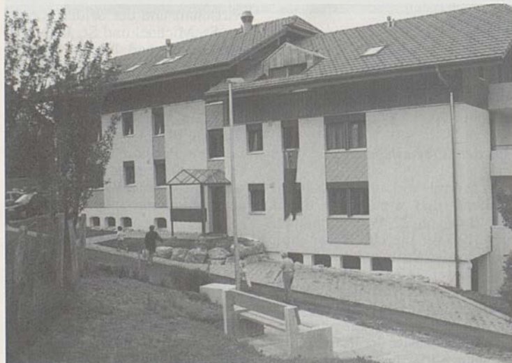
Eine gemeinnützige Stiftung hat auf der Kaplaneimatte 11 alters- und behindertengerechte Wohnungen errichtet.
