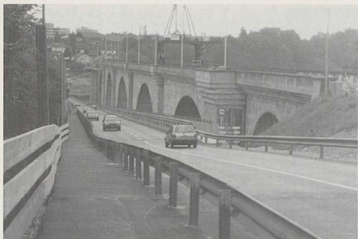
Um die Pérolesbrücke sanieren zu können, musste eine Notbrücke erstellt werden.
