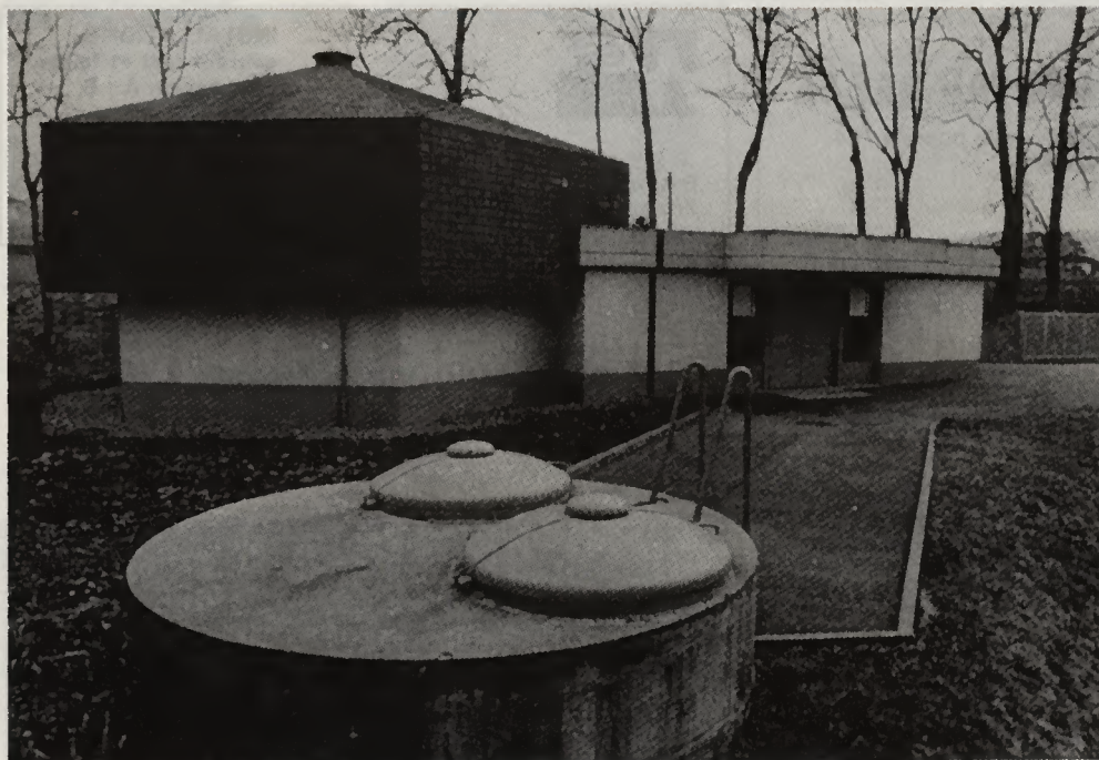
Le puits de captage et la station de pompage de Praroman.
