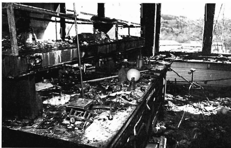
Der Labortrakt im Chemie-Institut der Universität wurde durch einen Grossbrand teilweise sehr stark zerstört.
