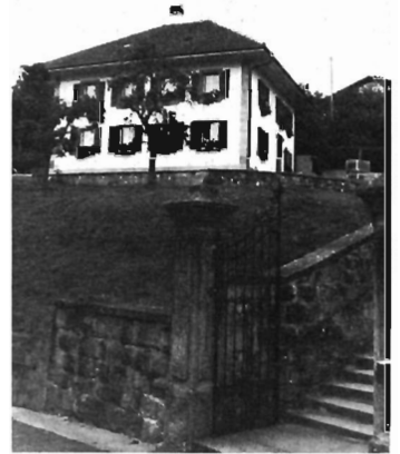
Das Pfarrhaus in Plasselb wurde einer vollständigen Aussenrenovation unterworfen.
