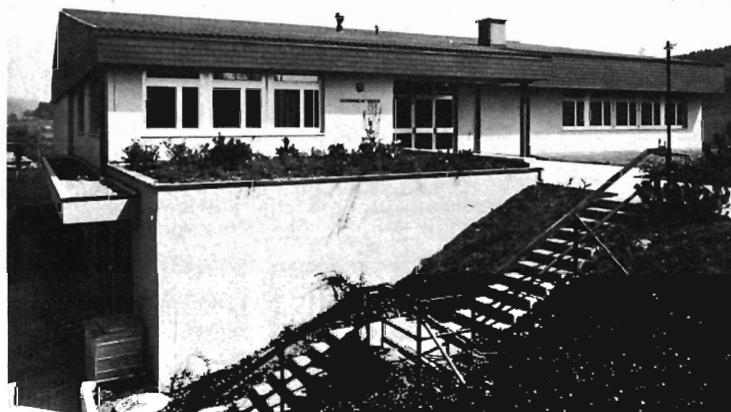
Am 2. Mai 1981 wurde das neue Mehrzweckgebäude in St. Ursen offiziell mit einem grossen Fest eingeweiht. Hier eine Ansicht des Eingangs zum Verwaltungsteil und zum Mehrzwecksaal.
