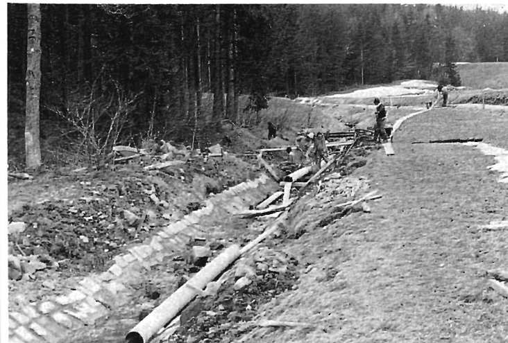
Der Dütschbach musste nach schweren Überschwemmungen neu verbaut werden.
