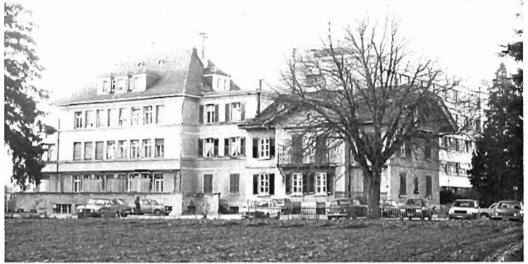
Die alten Bauten des Spitals Merlach sollen einem Neubau für Chronischkranke Platz machen.
