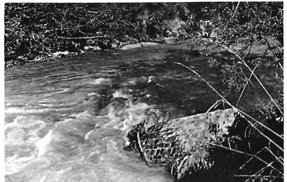
Sporen in der Sense sollen den Fluss «zähmen» helfen. (Foto aus dem Lehrbuch «Der Kanton Freiburg»)
