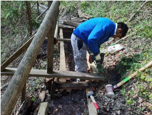
Unterhaltsarbeiten beim Wanderweg zur Grotte
