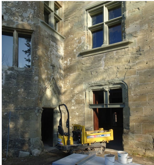
Ansicht des Donjons von Südwesten. Die beiden ebenerdigen Zugänge verraten, dass der Turm nicht als Wehrbau konzipiert wurde.
