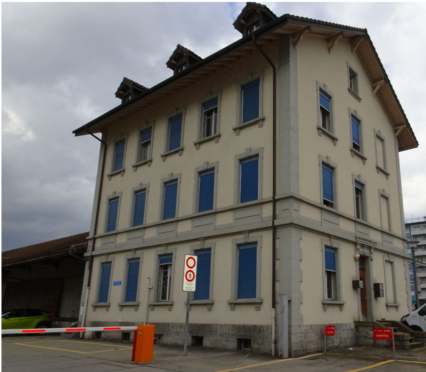
Place de la nouvelle Gare, passage Bauregard
