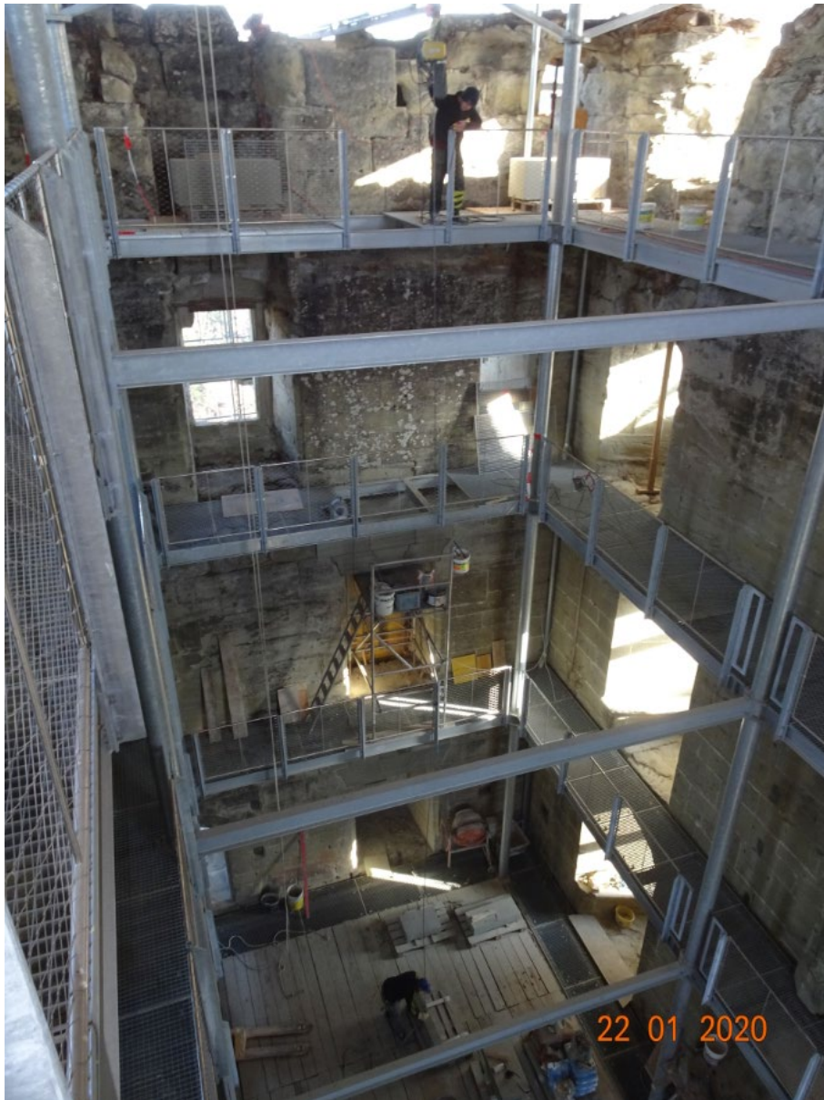
Restaurationsarbeiten im Innern des Manoirs.
