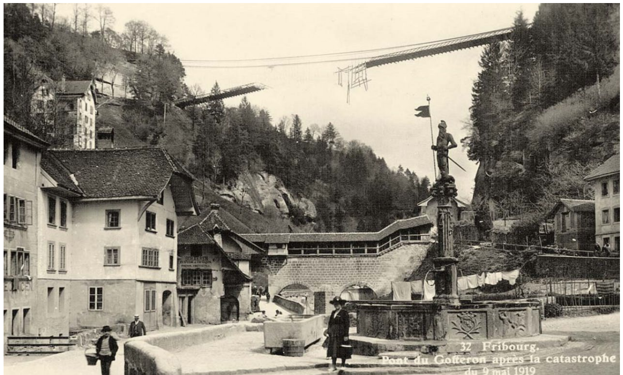
Das Bild der zerstörten Gottéron-Brücke hat sich ins Gedächtnis der Freiburger Bevölkerung eingebrannt.
