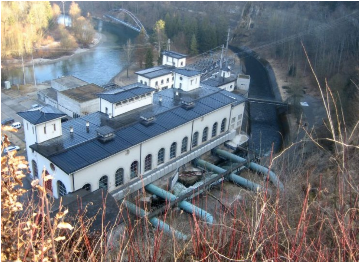
Das Wasserkraftwerk Hauterive turbinert das vom Rossens-Damm zurückgehaltene Wasser. Druckstollen mit 5 m Durchmesser, der das Betriebswasser zur 6 km entfernten Kraftwerkzentrale Hauterive leitet.
