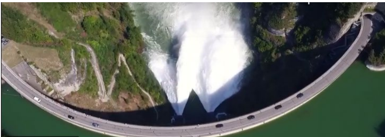
Künstliches Hochwasser für die Saane (Hochwasserentlastung der Stauanlage)
