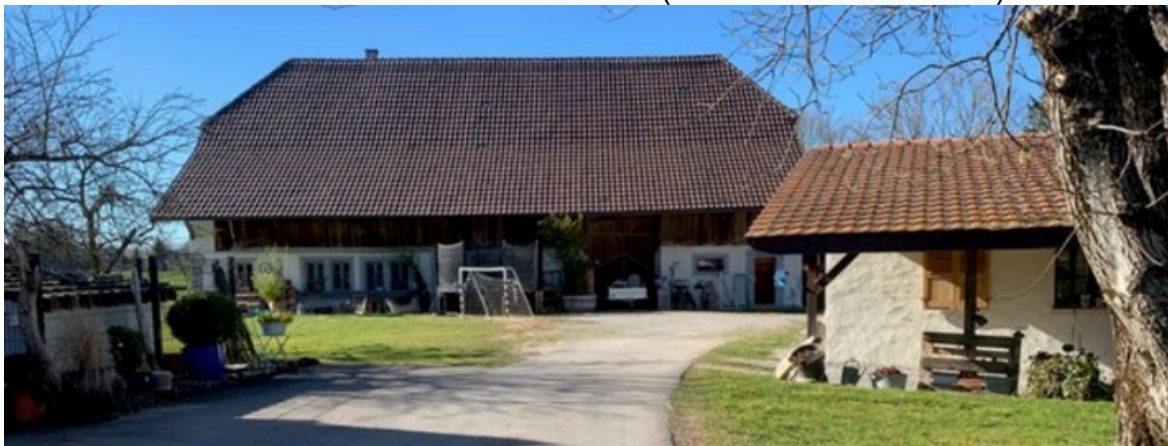
Bauernhaus Le Pré aux Moines (Route de Chésalles 74)
