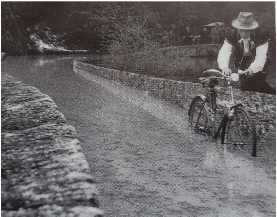
Der letzte Benützer der Thusy-Brücke
