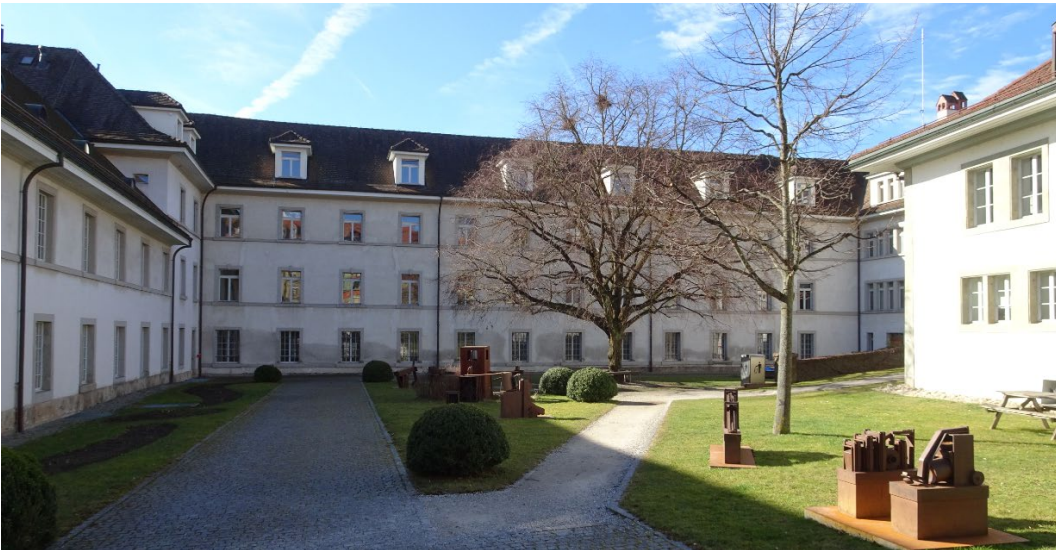
Après la restauration, l'aile Nord agrandie et surélevée.
