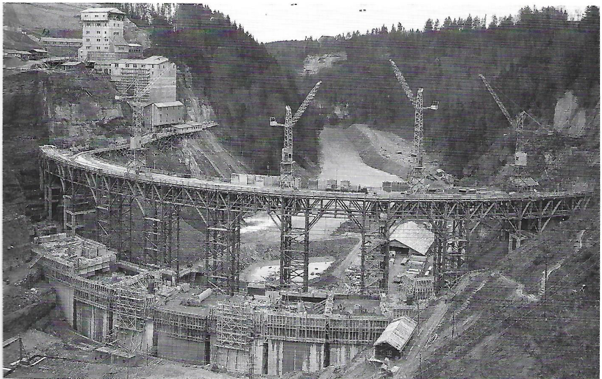
Die Staumauer im Bau mit der Betonierungsanlage.
