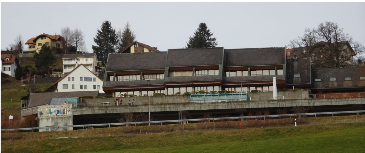
Autobahn-Raststätte Gruyère vom Seestrand aufgenommen.
