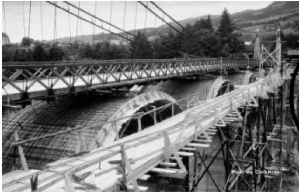
Construction du nouveau pont de Corbières, avec l'ancien 1931.
