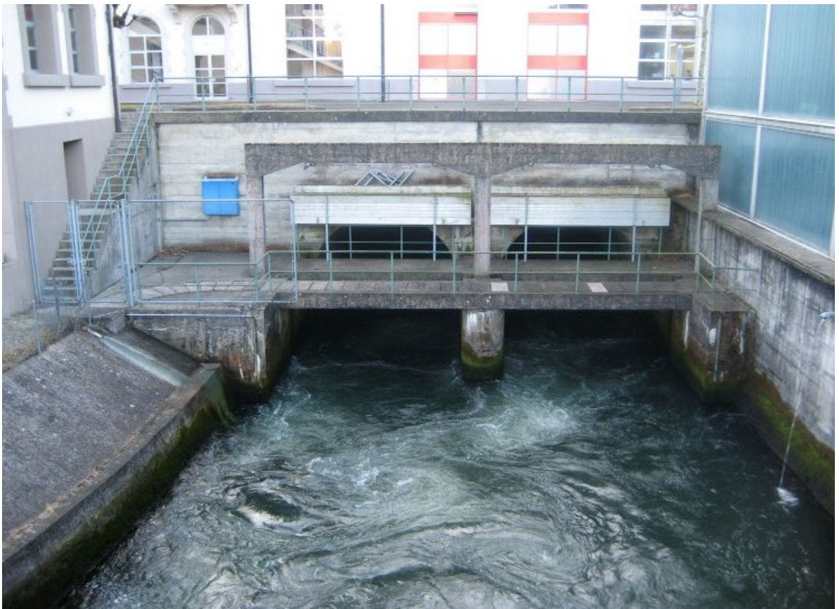
Ein Teil des turbinierten Wassers verlässt das Wasserkraftwerk und reicht bis unter die Petite Sarine.
