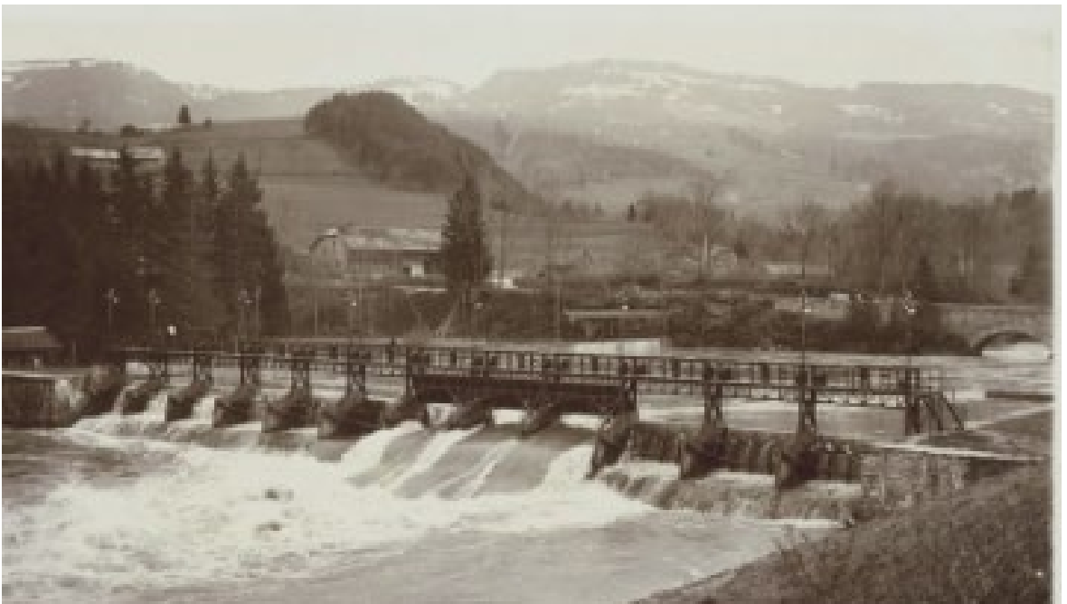
Barrage de Thusy 1930
