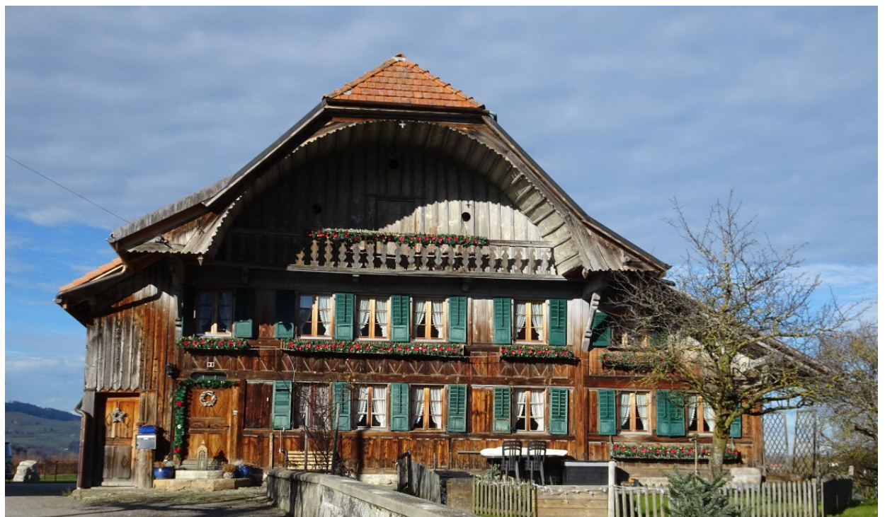
Wohnhaus (Kat: B =regionale/Kantonale Bedeutung)
