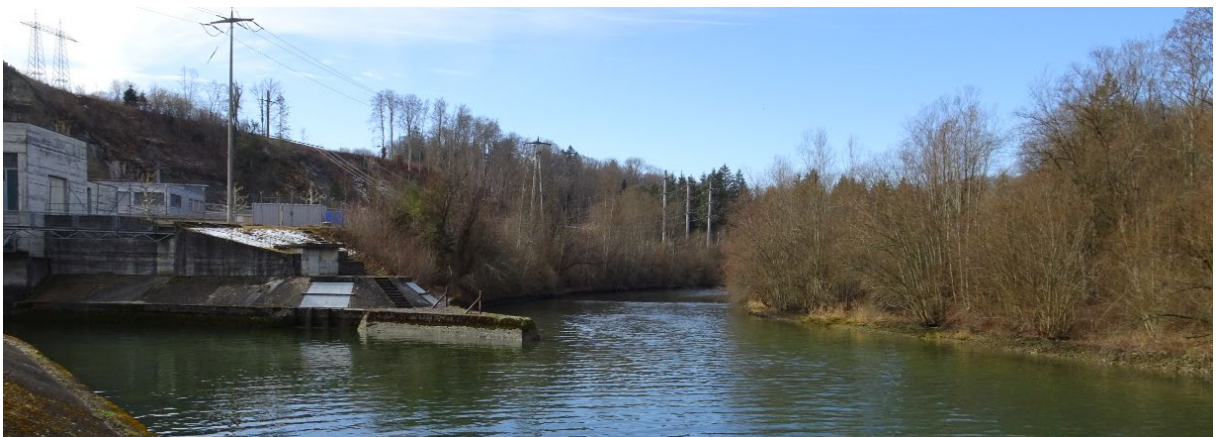
Das Kraftwerk Hauterive
