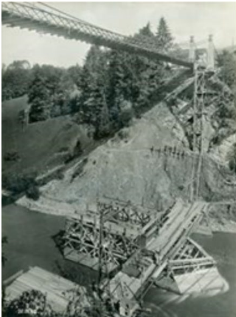
Construction du pont de Corbières et ancien pont suspendu 1930. Photographie de Buchs Victor
