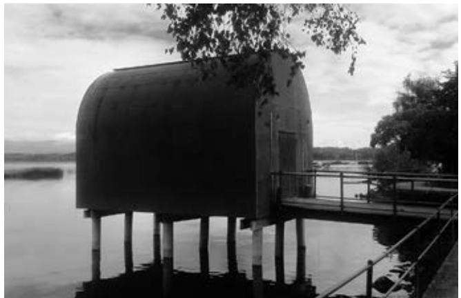
Die LACabane wird zur Sanierung abtransportiert.
