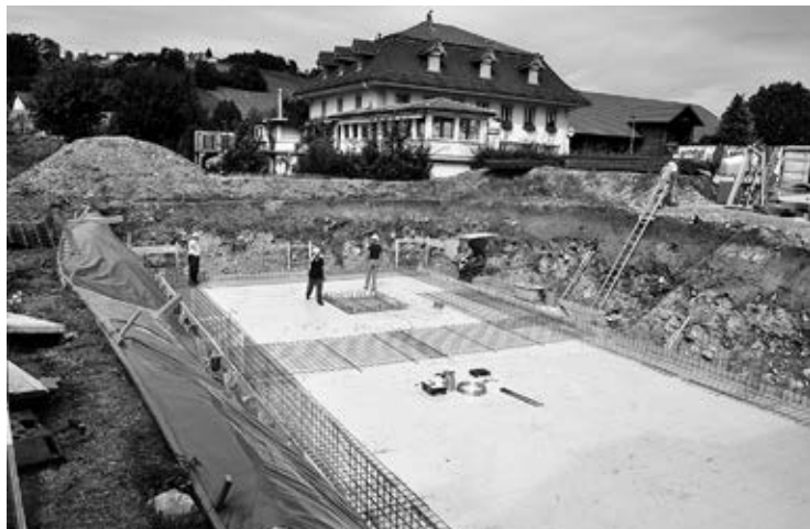
Fundament für den neuen Pfarrsaal.
