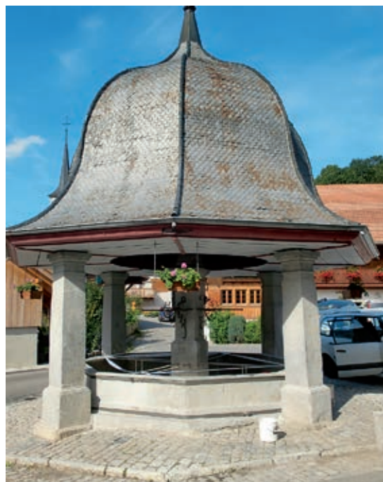
Der gedeckte Brunnen von Lessoc: Daniel und Sabine Burla führen auch in der weiteren Umgebung Restaurierungsarbeiten aus.
