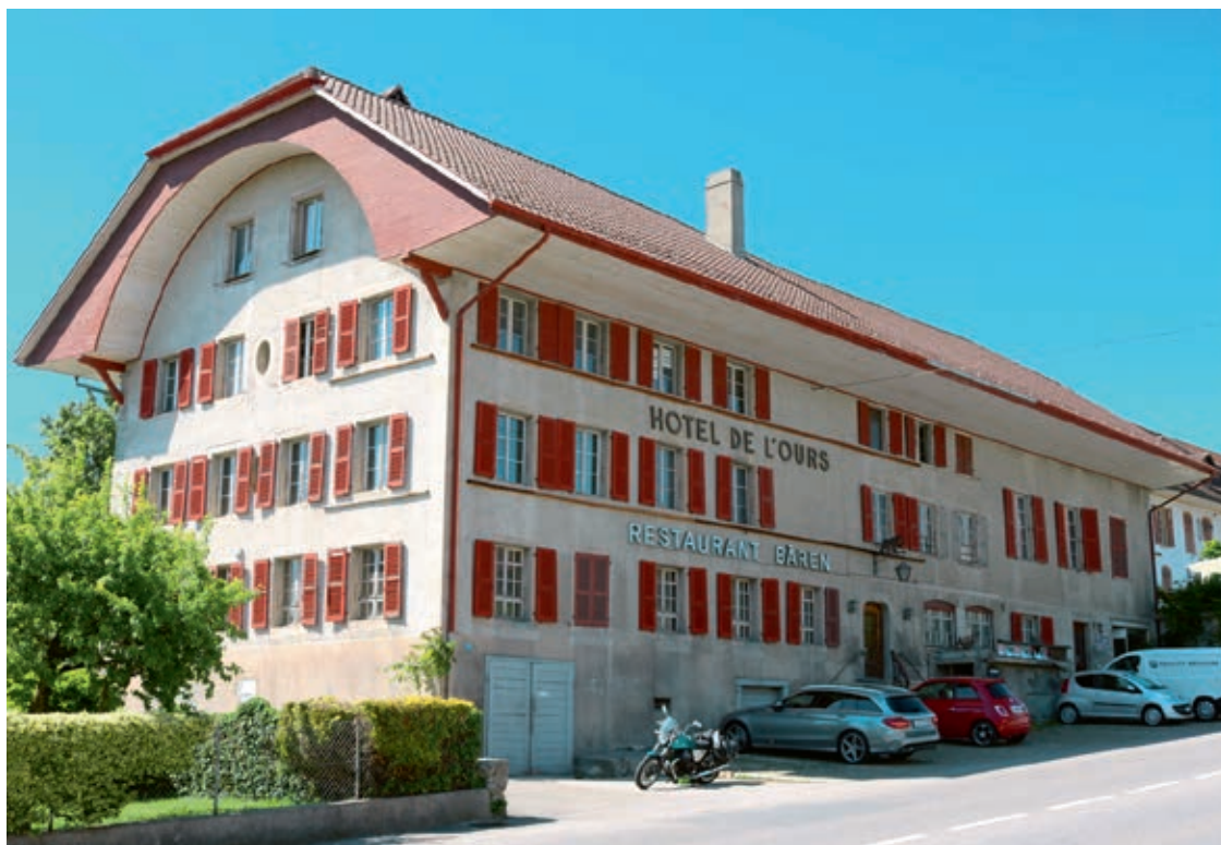
Der seit Sommer 2017 leerstehende «Bären»: Ab 2023 sollen im denkmalgeschützten Gebäude neun Wohnungen entstehen. Bild Christophe Zürcher
