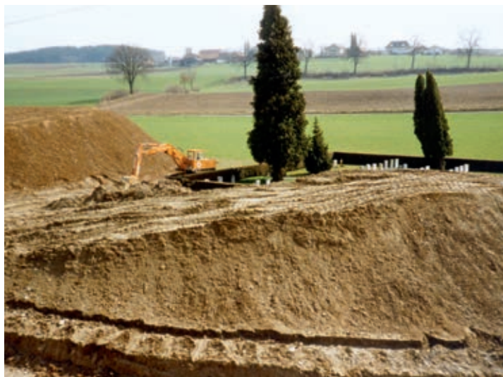
Vorbereitungsarbeiten auf dem Bohrareal: Dieses befand sich in unmittelbarer Nähe des Friedhofs Fendringen. Bild Archiv Gemeinde Böisingen
