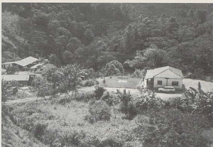
Die Fazenda «Nova Horcón» in Rio Claro am Rande des Urwaldes. Links im Bild das Ökonomiegebäude mit dem Angestelltenhaus.
