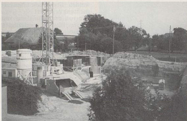
Schutzräume werden in die Tiefgaragen von drei Mehrfamilienhäusern integriert.
