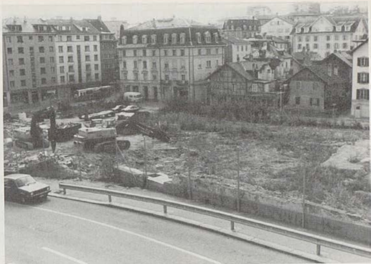
Im Beaugard-Zentrum wird jetzt gebaut.
