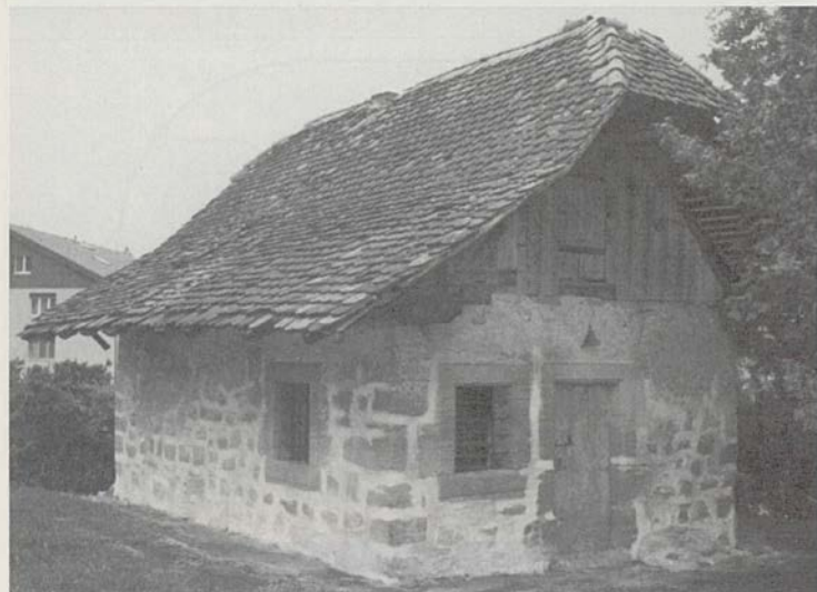
Die Pfarrei restauriert das Pfarrei-Ofenhaus.
