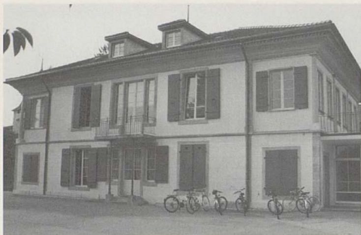
Die Fassade des Schwesternhauses nach der gelungenen Renovation.
