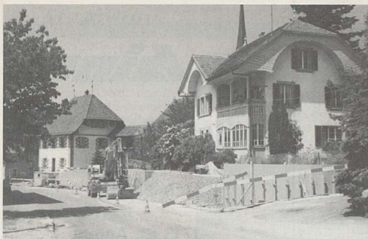
Trottoirbau im Dorfzentrum
