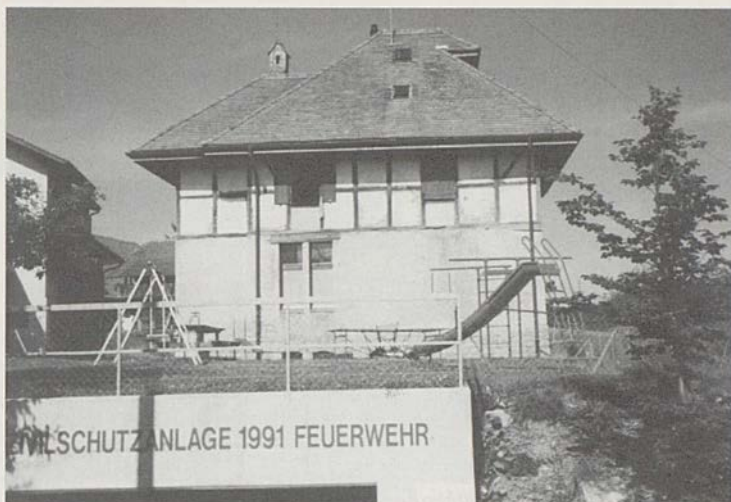
Über der Zivilschutzanlage konnte auf den Sommer hin ein willkommener Spielplatz errichtet werden.
