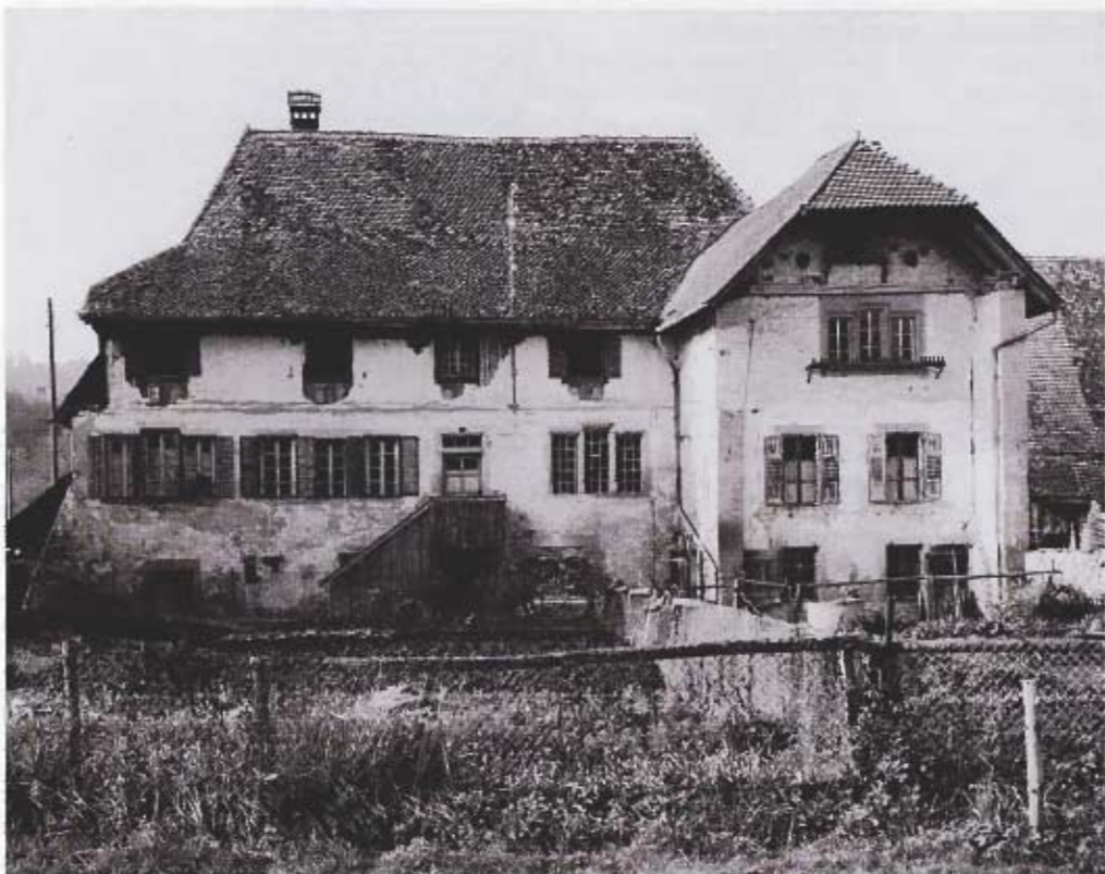
Façade Est: L'agrandissement du bâtiment a eu lieu vers la fin du XVI e siècle. Le «châtelet» gothique du milieu du XVI e siècle est la partie la plus ancienne de la maison.
