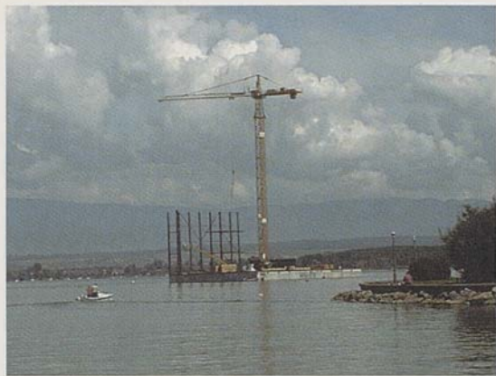
Die Plattform für den schwimmenden Monolithen wiegt ungefähr 600 Tonnen. (Foto Urs Höchner, Juli 2001)
