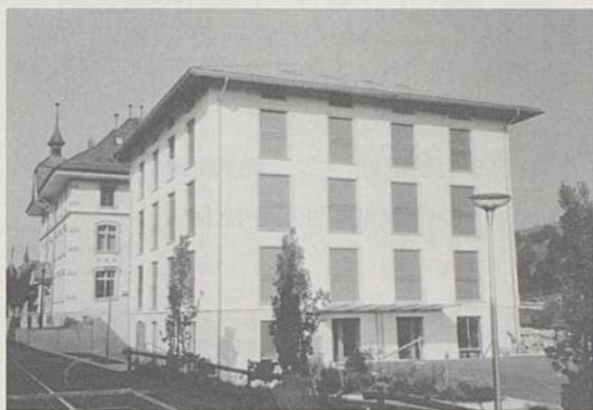
Das Primarschulhaus wurde mit einem Anbau erweitert.
