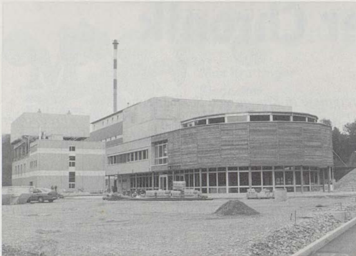
Die Kehrrecht-Verbrennungsanlage in Châtillon nahm ihren Betrieb auf.
