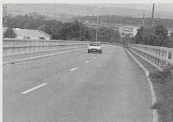
Die Autobahnbrücke Widalmi wurde saniert.
