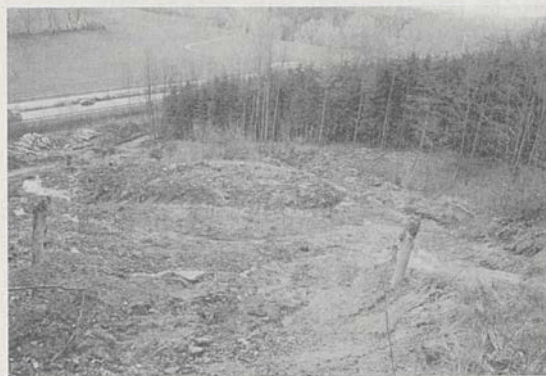
Die Sanierung einer Hangrutschung bei der Bibera, wo früher eine Deponie war, verursachte hohe Kosten.
