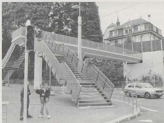
Neue Fussgängerüberführung beim Bahnhof in Richtung Gambahquartier.
