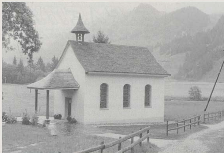
Die Marienkapelle in Schwarzsee wurde innen und aussen renoviert.
