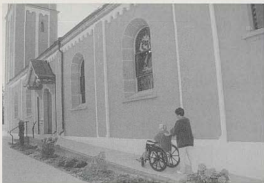
Die jetzt auch aussen renovierte Kirche – neu mit einem behindertengerechten Zugang – erscheint in neuem Glanz.
