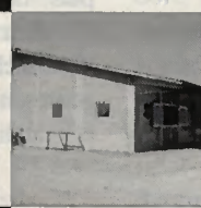
Ecuries en éléments préfabriqués en béton
