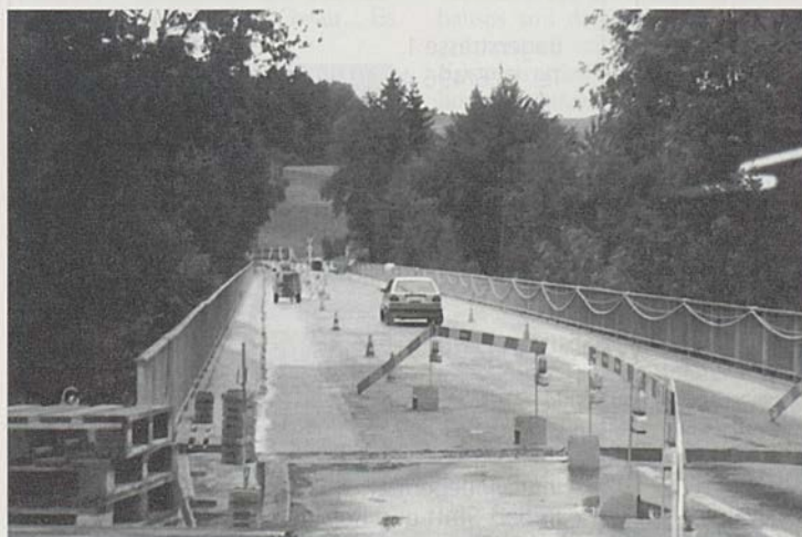
Die Brücke über die Galtera zwischen St. Ursen und Tafers wurde saniert.
