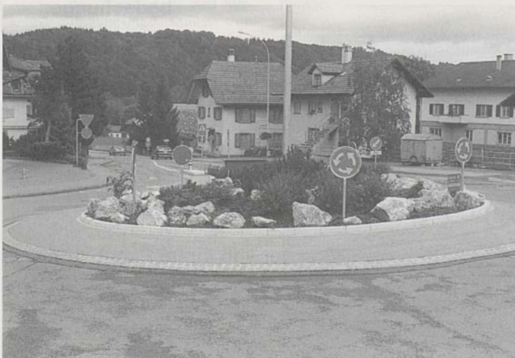
Ein Kreisel erschliesst neuerdings die Wohnüberbauung Obere Tuftera.
