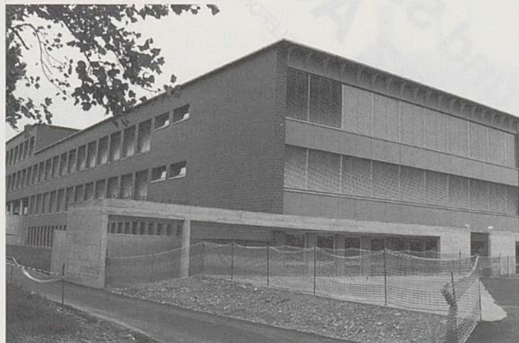
Das neue Orientierungsschulgebäude konnte auf Schulbeginn 98/99 bezogen werden.
