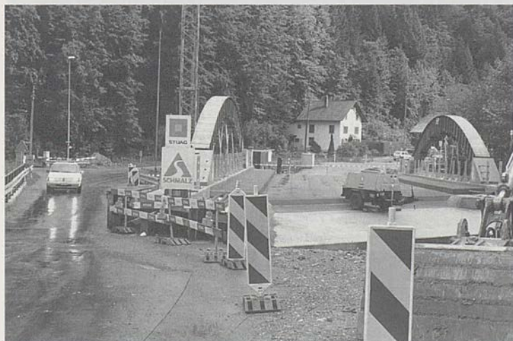
Ab Februar 1998 wurde eine neue Zollhausbrücke gebaut (Aufnahme Mitte September).
