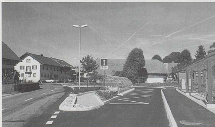
Neu erstellter Bus-Wendeplatz mit Personen- und Velounterstand in Niedermettlen
