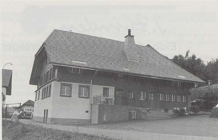
Das Gebäude Nr. 24 steht unter Heimatschutz. Es bildet einen Teil des einheitlichen Dorfbildes und soll deshalb erhalten bleiben. Es wurde soeben aussen renoviert.
