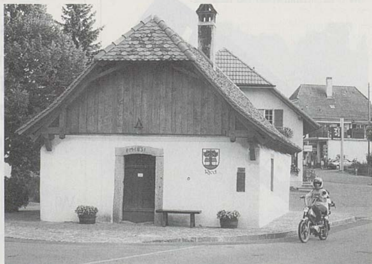
Das Ofenhaus aus dem Jahre 1831 wurde saniert. (Foto Ueli Gutknecht)
