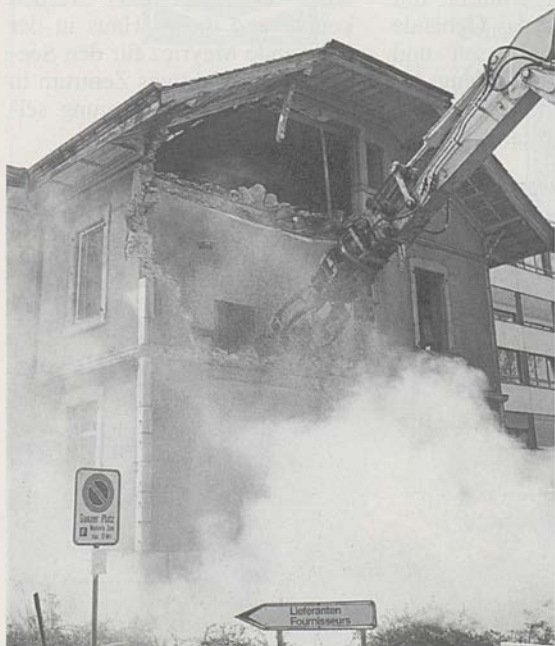
Der Abbruch beginnt
