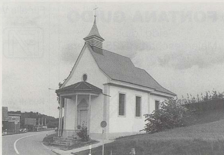
Nach der Aussenrenovation erscheint die Kapelle Mariahilf in neuem Glanz.
