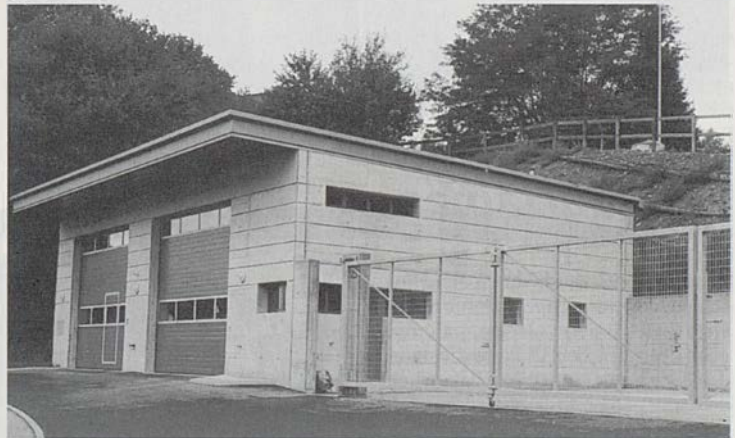
Ein Werkhof mit Feuerwehrdepot und wurde in Pensier gebaut.
