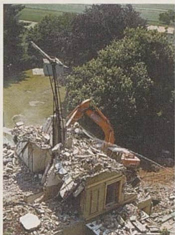
Der Abbruch ist bald vollendet
