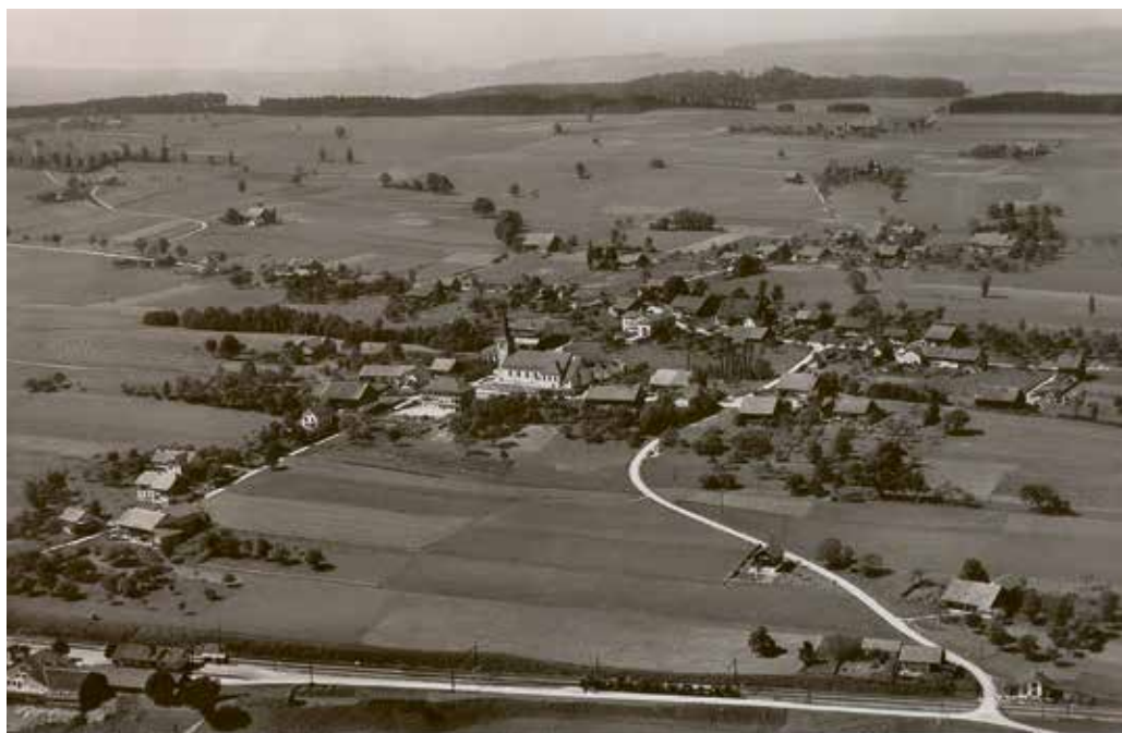
Vue aérienne de Siviriez, entre 1940 et 1950.
