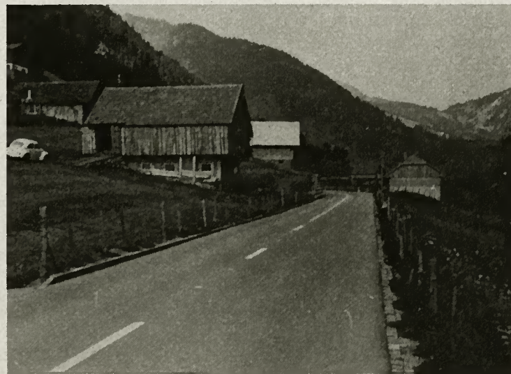
Le danger sera le même pour ces granges et habitations après la construction de la galerie Photos Bd
