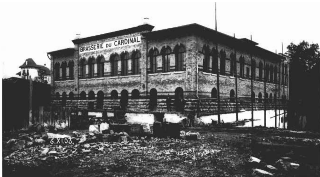
Le nouveau bâtiment de la brasserie à proximité de la gare. La construction s'achève en 1906. A l'arrière plan, la maison des patrons, aujourd'hui démolie.
