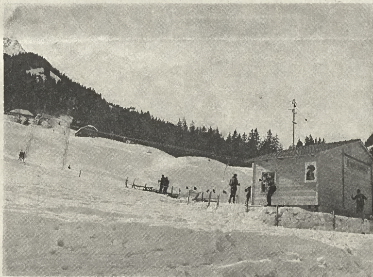
La station de départ du nouveau télési.
