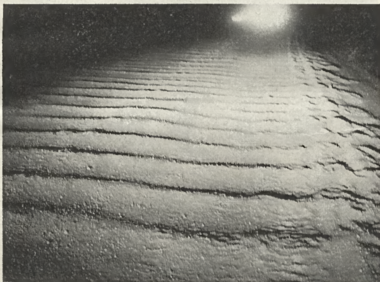
La piste, appelée tôle ondulée.
