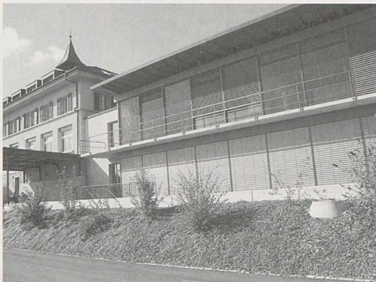
Das Schulhaus wurde mit einem neuen Anbau (rechts) erweitert.
