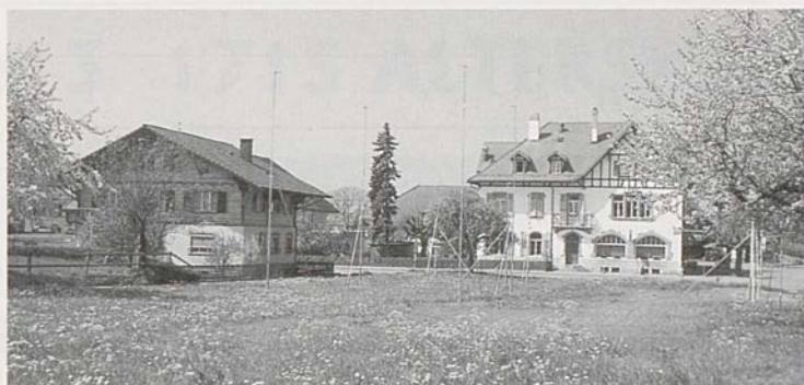
Hier wird die neue Kirche der evang. Ref. Kirchgemeinde gebaut.
