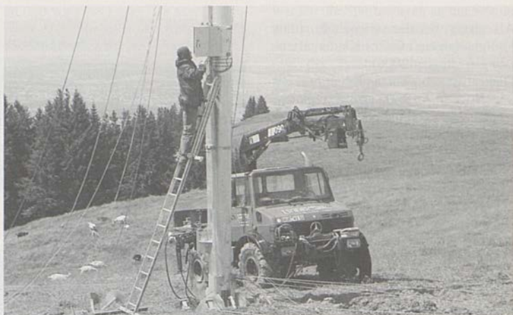
Installation eines Windmessmasten auf dem Schwyberg.
