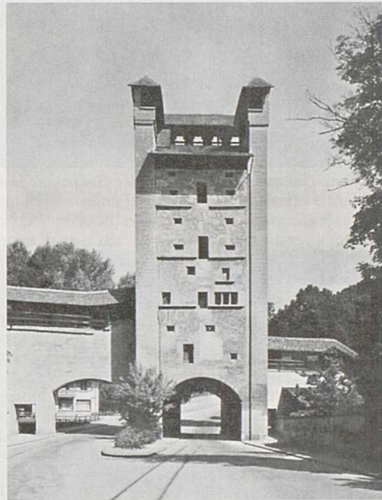
Ansicht des Murtentores stadtseits nach der Realisierung des zweiten Durchgangs 1950/51 und mit den deutlich erkennbaren Tramschienen. Bild aus: Les monuments d'art et d'histoire du canton de Fribourg , Bd. 1, Basel 1964, S. 181
