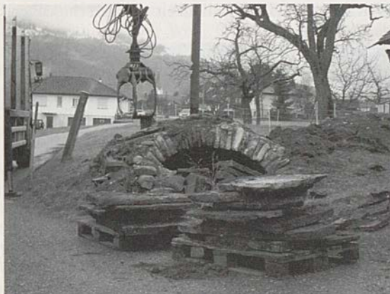
Der Kabiskeller von Bifig/Oberschrot im Abbau. Gewölbe und Deckplatten werden auseinandergenommen.
