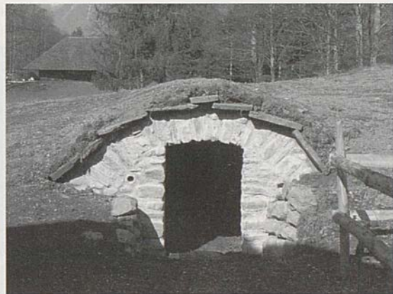
Die wieder hergestellte Eingangsfront des Kellers im Museum
