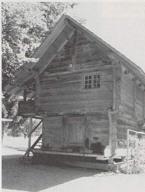
Der Speicher beim Pfarreizentrum wurde mit vielen freiwilligen Arbeitsstunden renoviert.
