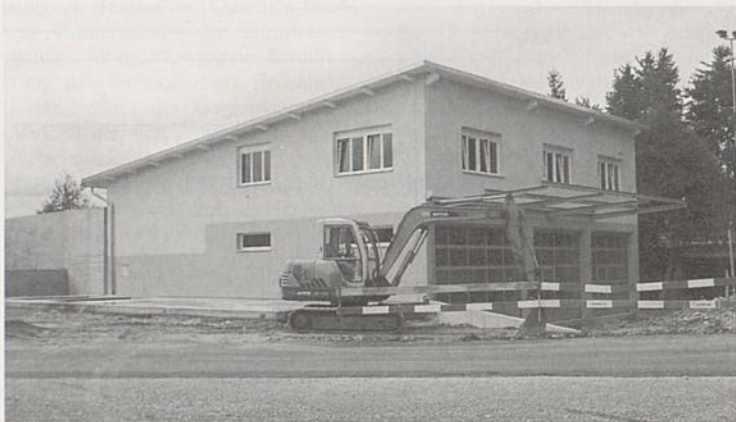
Seit Dezember 2006 ist das Mehrzweckgebäude in Gwatt im Bau.
