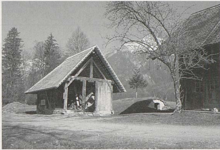
Ofenhaus und Keller am neuen Standort im Museum
