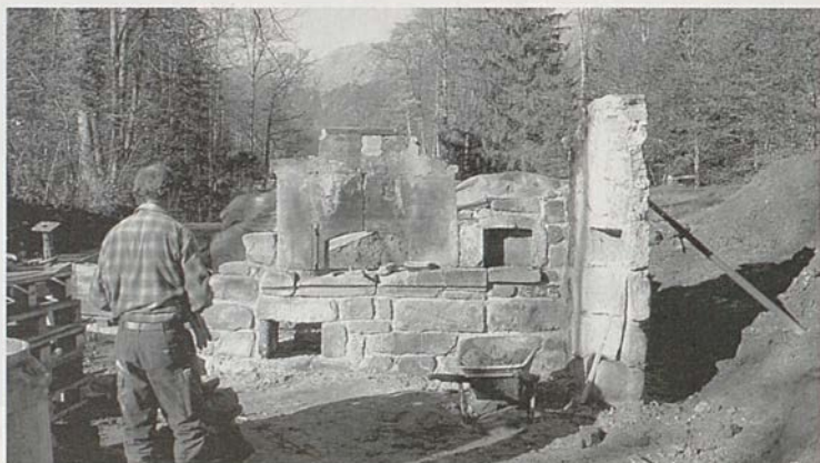
Der Wiederaufbau im Ballenberg setzte mit der Front des Backofens ein.
