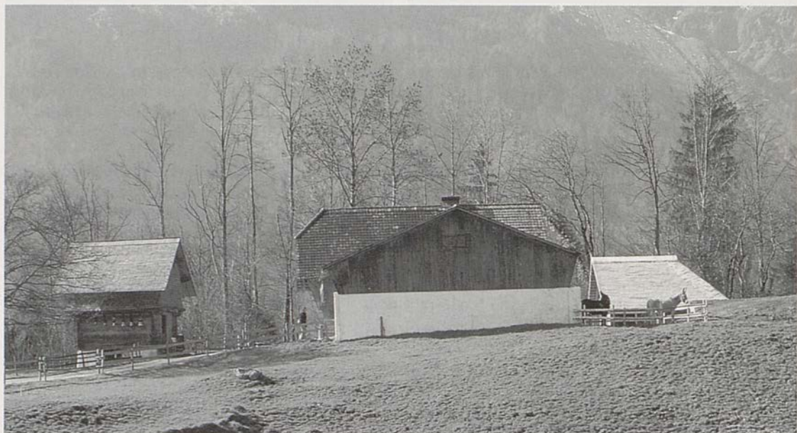
Die neue Gesamtansicht der Sensler Hofgruppe im Ballenberg, von links: Speicher, Bauernhaus, Ofenhaus, davor (verdeckt) der Kabiskeller
