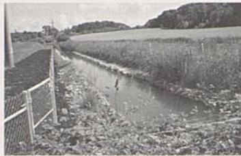
*Das Sandfangbecken des Baches soll verhindern helfen, dass es bei starken Regenfällen zu Rückstauungen und zu einer möglichen Überflutung der Autobahn kommt.*
