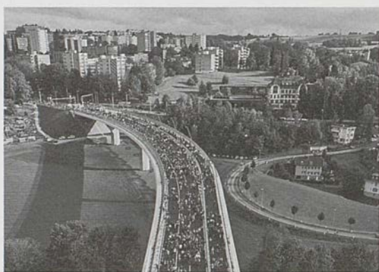
Die Freiburger liessen sich die Einweihung der neuen Brücke nicht entgehen.
