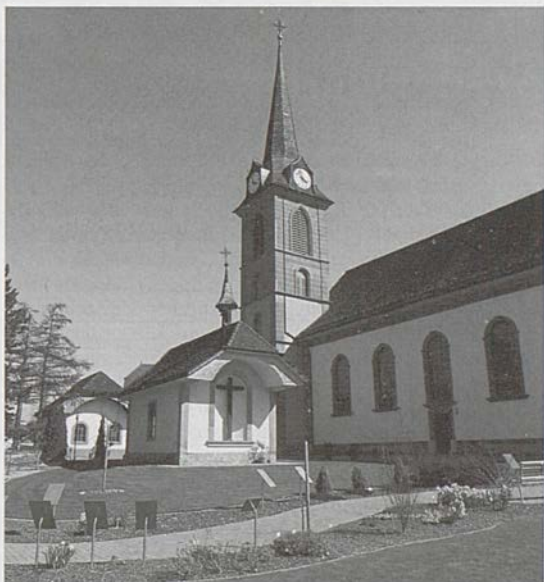
Die Renovationsarbeiten an der Kirche sind abgeschlossen.
