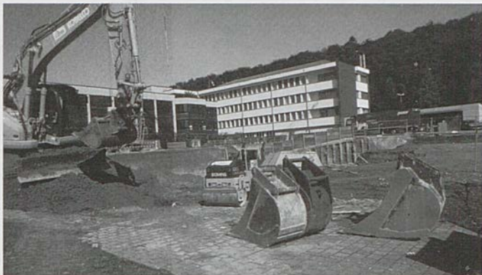
Die Bauarbeiten für die neue Demenzstation sind in vollem Gang.
