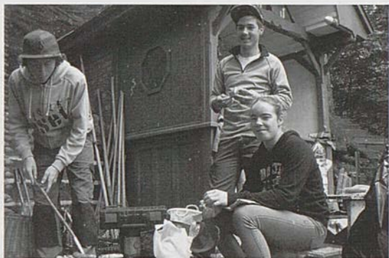
Sanierung der Fuhr-Grotte: Verdiente Verpflegungspause. Bild zvg
