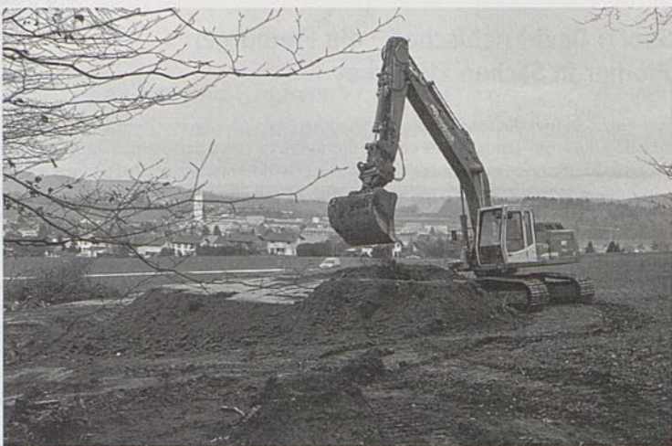
Erster Spatenstich für das neue Reservoir in Courtepin.
