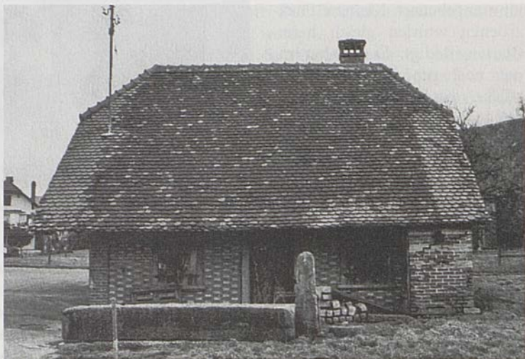
Seitenansicht mit dem alten Brunnen, von dem es noch zwei modernere Ausgaben innerhalb des Waschlokals gibt.
