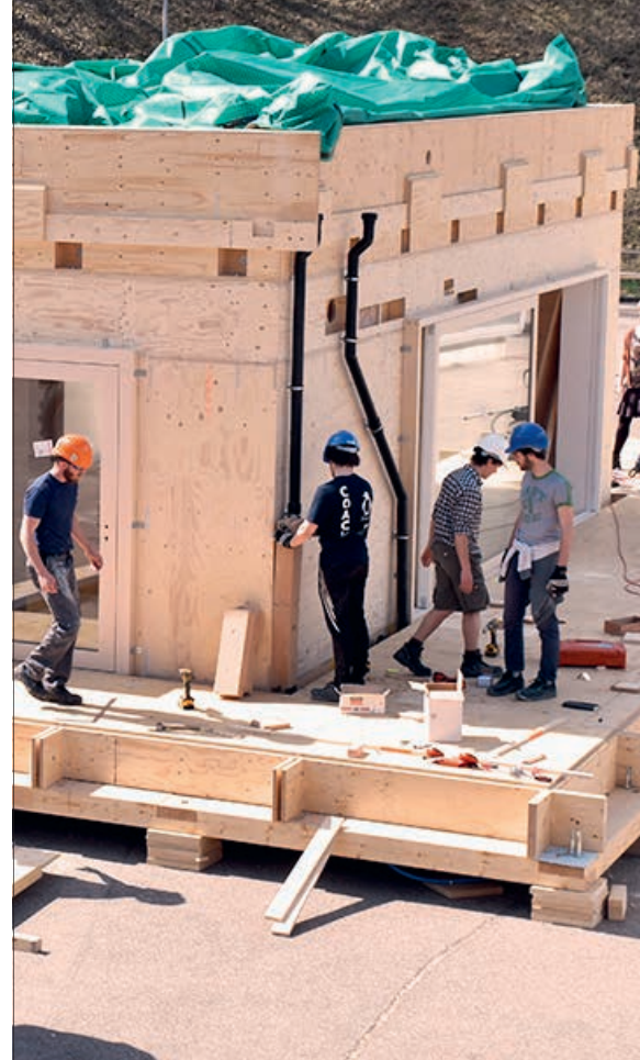
Le chantier © DR
