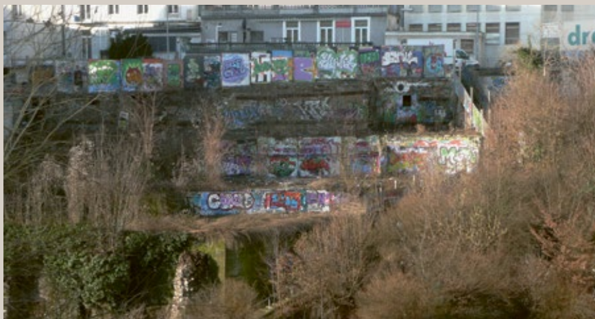
Le haut de la route Neuve où devrait être aménagé l'accès au nouveau parking.
