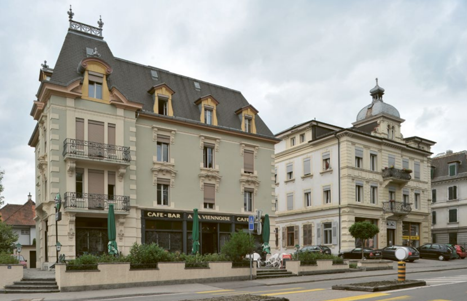
L'immeuble de la Viennoise, rue de Gruyères 90, construit en 1905-06 par l'entrepreneur Charles Folghera, pour le poëlier-fumiste Adolphe Egli, sur les plans de l'architecte bullois Louis Weber.
