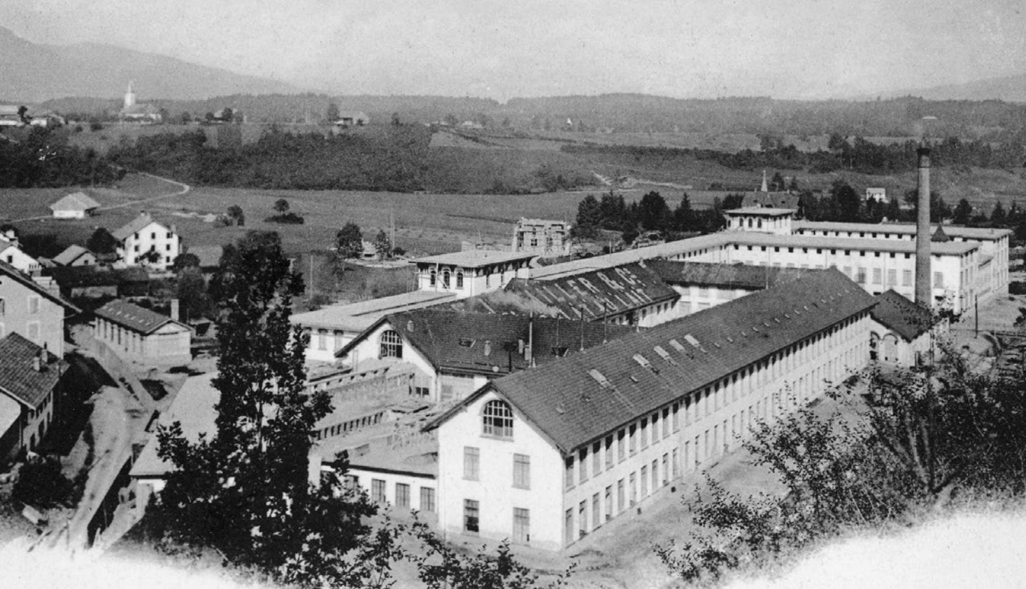
Au premier plan: les premiers bâtiments, puis le premier agrandissement, peu après 1900.
