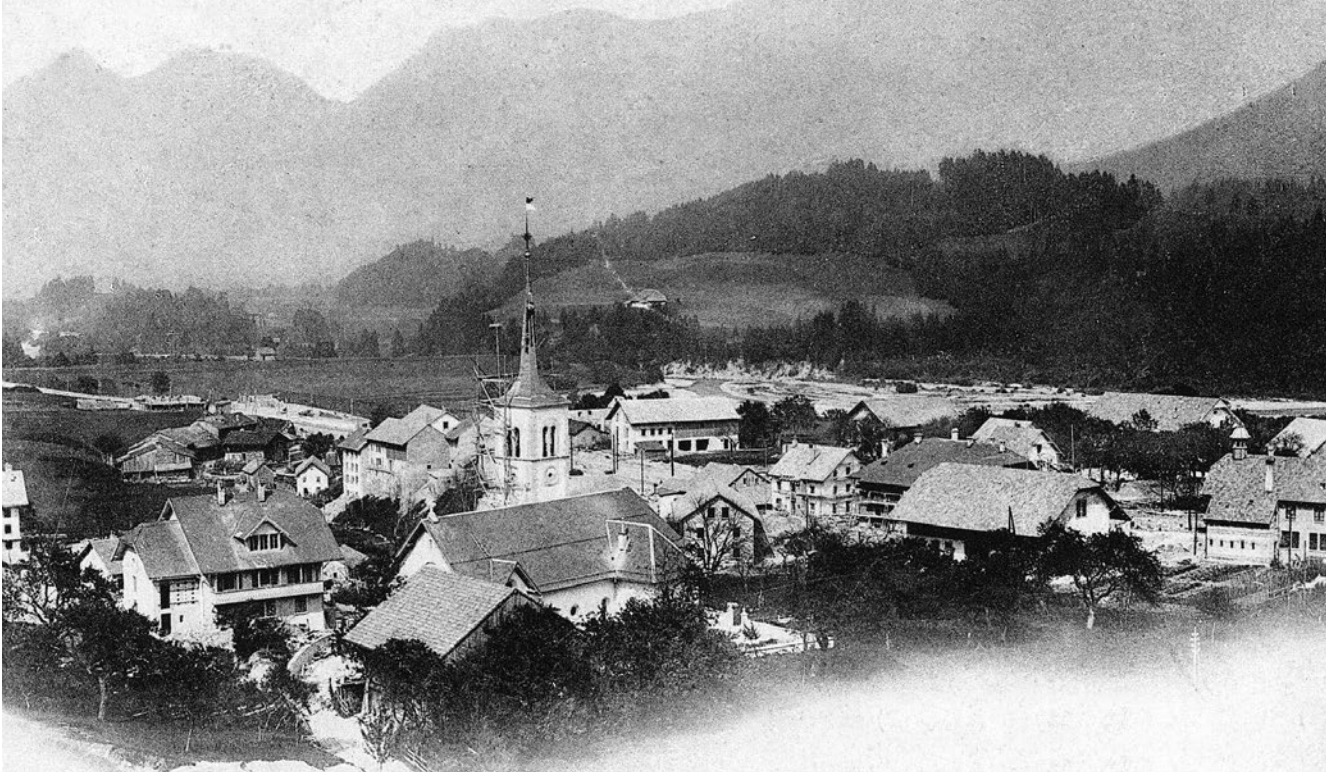
Neirivue en pleine reconstruction après l'incendie de 1904.
