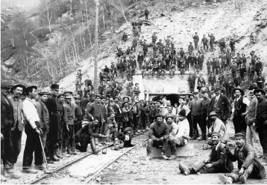
Mineurs italiens sur le chantier du tunnel du Simplon en 1899.
