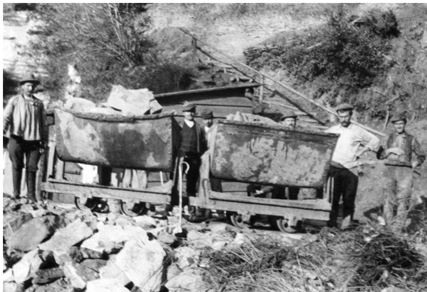
Le chantier du tunnel de Thusy, au début du XX e siècle.
