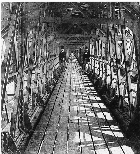
Le cheminement piéton de l'ancien viaduc de Grandfey, inauguré le 2 septembre 1862. (Photo du temps)
