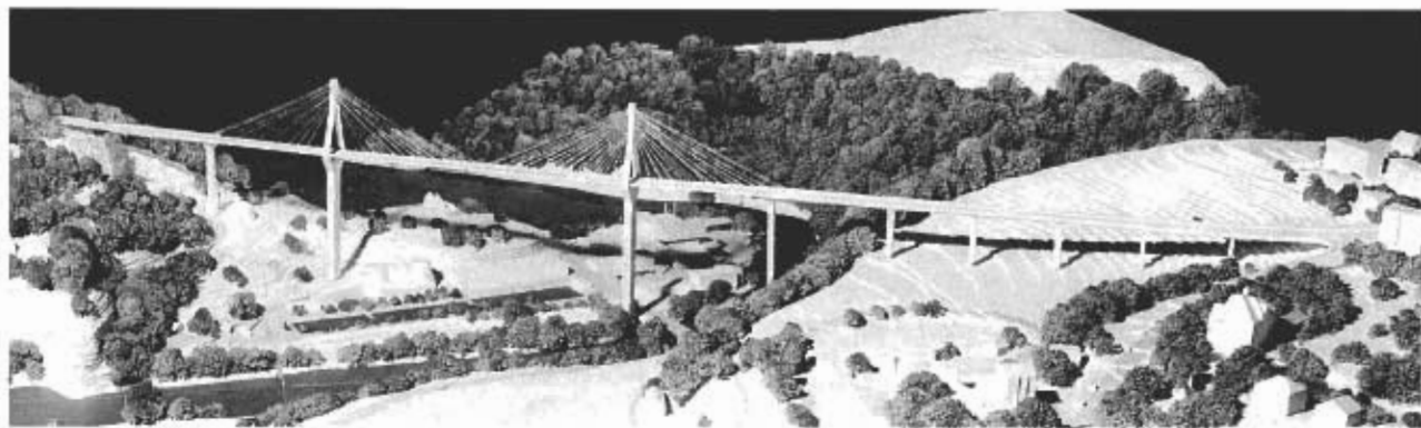
Pont haubané de 631 m, tel que vu de la tour de la cathédrale.
