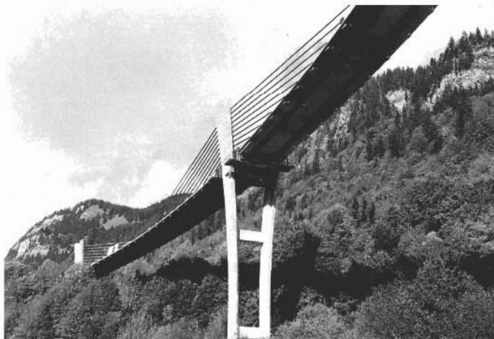
Une alternative novatrice: le pont du Sunniberg à Klosters (1996-98). Concept: Christian Menn. Maître d'œuvre: Canton des Grisons.
