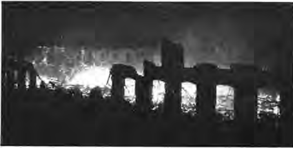
Der Brand nach dem Einsturz des Dachstuhl.
