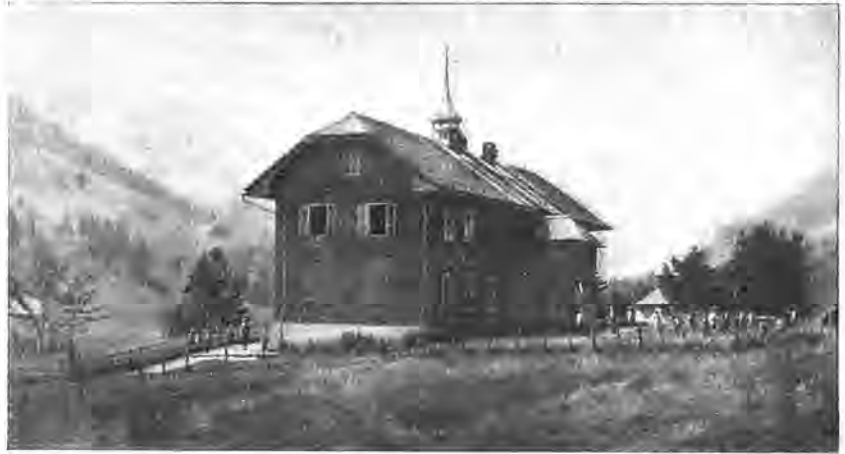
Schulhaus und Kapelle der Lichtenena
