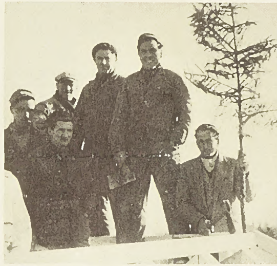
Les ouvriers après la pose du bouquet.
