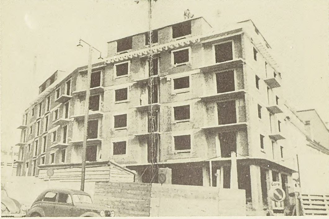
L'immeuble S. I. Nicolas à son stade actuel de construction.
