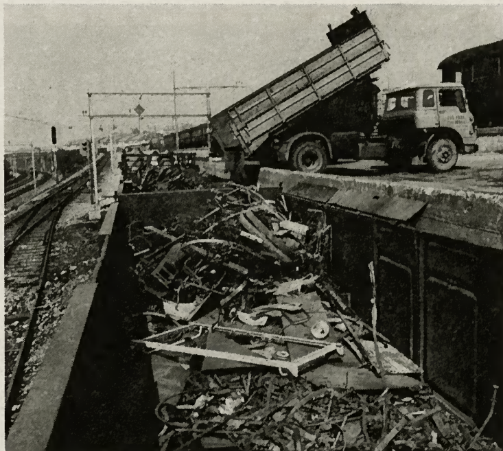
▼ La ferraille récupérée par la Maison Page est déversée dans des wagons CFF qui la conduiront à Gerlafingen.
