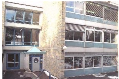
La bibliothèque est située dans le bâtiment de l'Ecole du cycle d'orientation de la Broye à Estavayer-le-Lac
