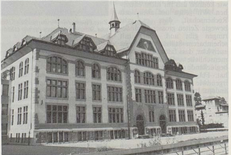
Die deutschsprachigen OS-Klassen der Stadt Freiburg befinden sich seit 1973 in diesem Gebäude an der Schulstrasse 5. In den Jahren 1978/79 erfolgte eine Totalrenovation des Gebäudes.
