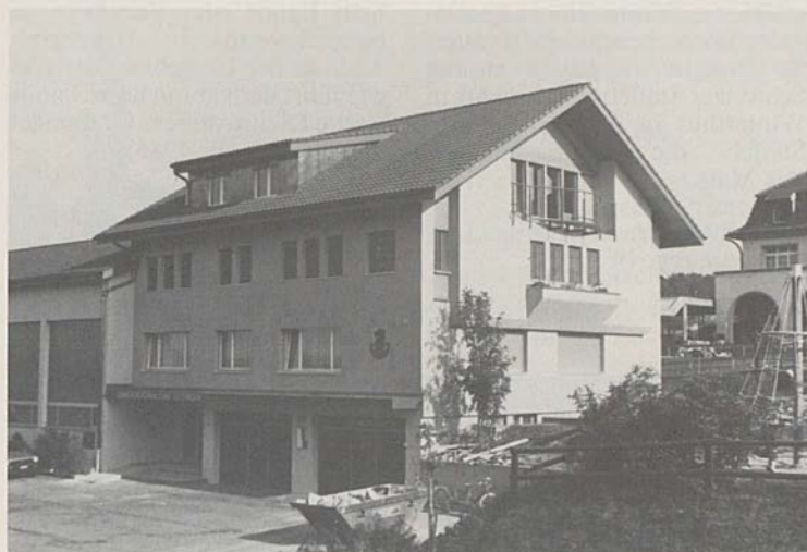
Wegen der rasanten Bevölkerungszunahme musste Bösingen die Gemeindeverwaltung vergrössern. Das Gemeindehaus wurde um ein Stockwerk erhöht.
