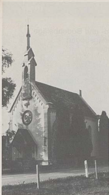
Die Pfarrei Dürdingen ist besorgt um ihre Kapellen. Nach Schiffenen wurde im Frühjahr die Renovation der Kapelle Bundtels (Bild) abgeschlossen. Zur Zeit ist nun die Renovation der Kapelle von Übewil im Gang.
