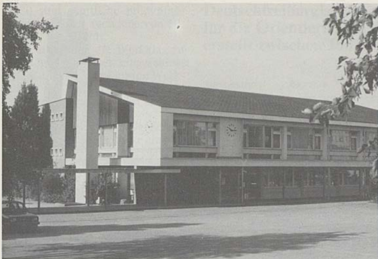
Das Sekundarschulgebäude in Dürdingen (Baujahr 1962/63)
