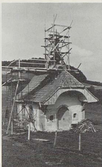
Die Kapelle in Hochstettlen wird einer Aussen- und Innenrenovation unterzogen.
