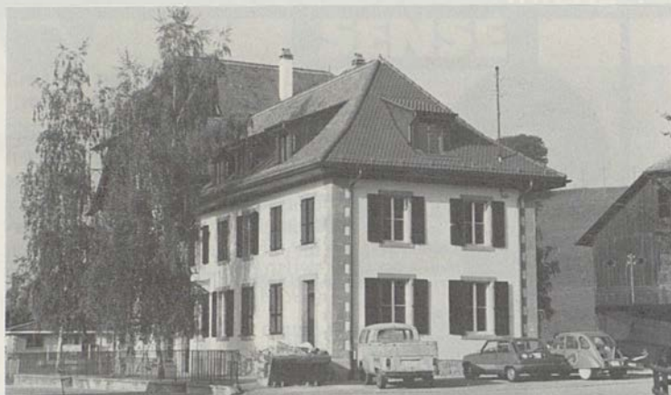
Die Renovation des Schulhauses in Bärfischen geht ihrem Ende entgegen.
