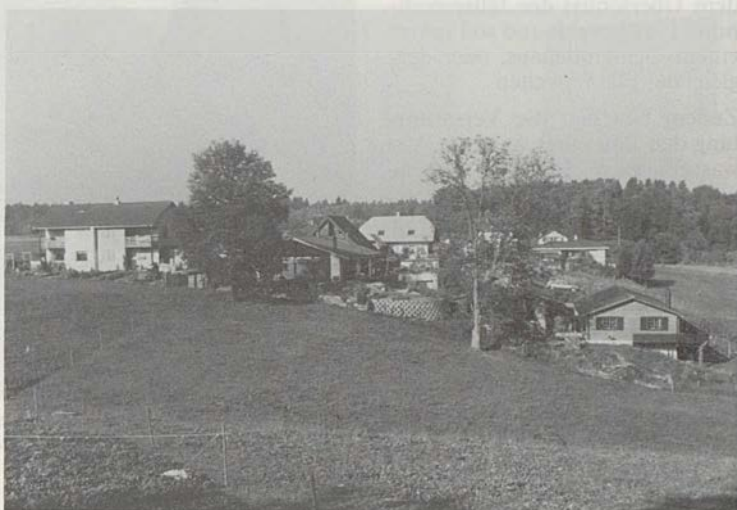
In diesem neuen Quartier in Kleinbösingen wurde in einem Einfamilienhaus auch der erste öffentliche Zivilschutzkeller mit 100 Schutzplätzen eingebaut.
