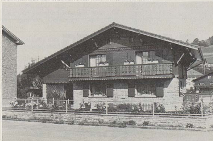
Das Lehrerhaus neben dem Schulhaus wurde renoviert.
