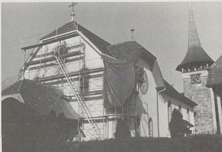
Im Sommer 1985 hat die Aussenrenovation der Pfarrkirche begonnen.
