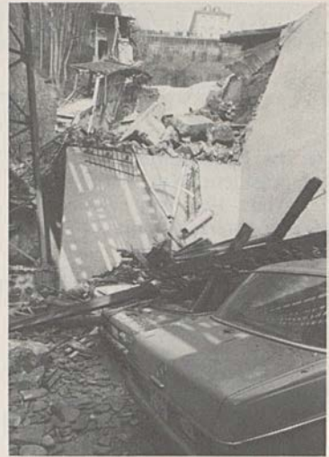
Teile der alten Stadtmauer sind im März 1985 eingestürzt. Dabei wurde die historische Treppe mitgerissen.
