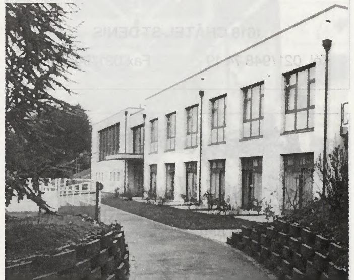
Le nouveau bâtiment baptisé «Espace culturel».
